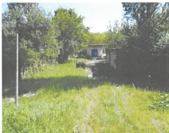
lebontandó épületek kívülről
